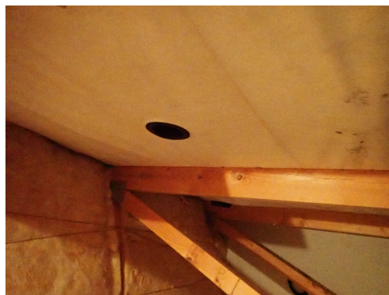
Foto: Ventilationsstuds i undertaget
