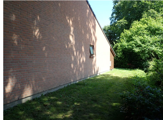
Foto: Opfugtede sokkel
